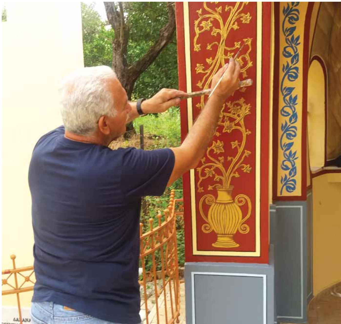
Παρεκκλήσιο, Παιδικός Σταθμός Εγλυκάδας
